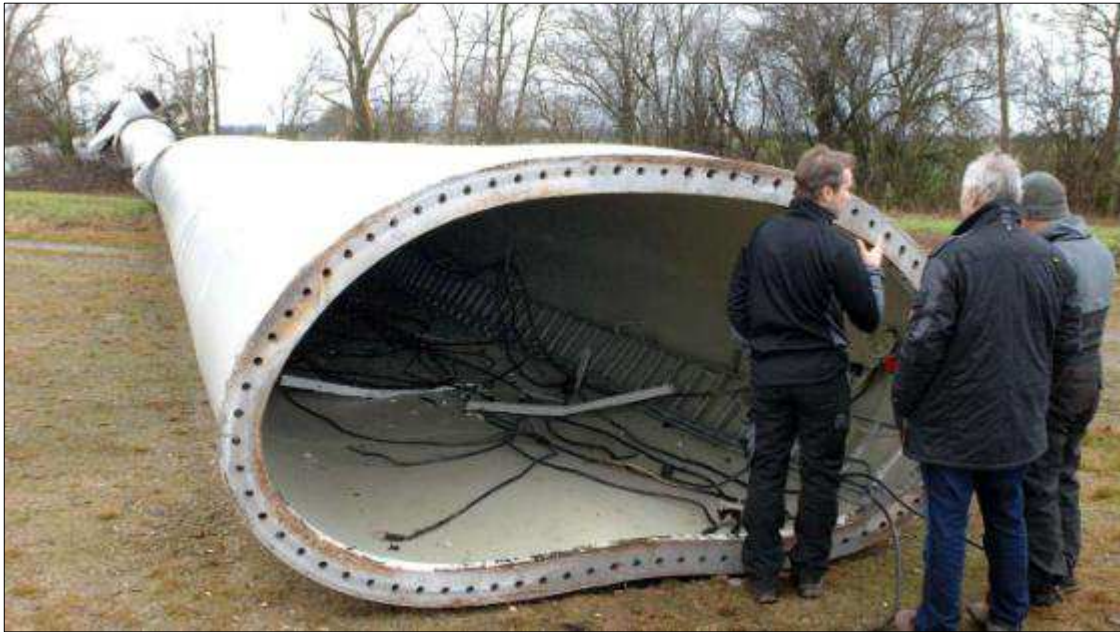
Hier stürzte ein Teil des 50-Tonnen-Windrads um. Zuletzt brach am 8. Mai 2007 an einem benachbarten Windrad ein Rotorblatt
