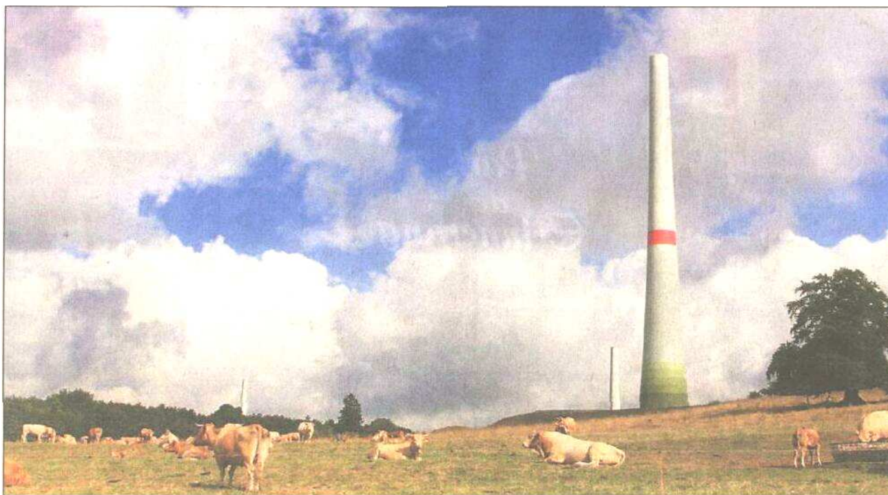
Wo Windräder wachsen: Driedorf und Greifenstein errichten derzeit Windräder auf dem Knoten. Das möchte auch Mengerskirchen. Geplant sind drei Anlagen mit einer Narbenhöhe von 140,6 Meter. Deren Türme sind beinahe so hoch wie der Kölner Dom (157,4 Meter). (Foto: Gerdau)
