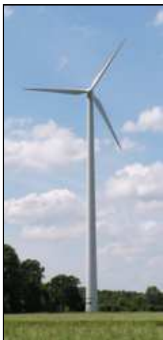
Windkraftanlage Quelle: BGR
